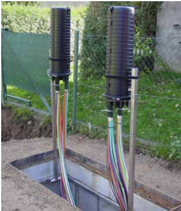
Einbaulösung in Mönninghoff P5 Betonschacht
