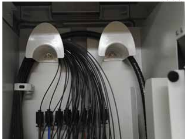
Detail Mikrokabelführung (Spleißbereich aufgeklappt)
