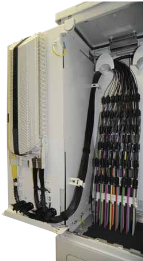
Abfangung Mikroröhrchen und Spleißbereich aufgeklappt
