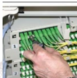
Speicherung eines Bildes am Patchfeld per Fotoauslöser direkt am Mikroskop
